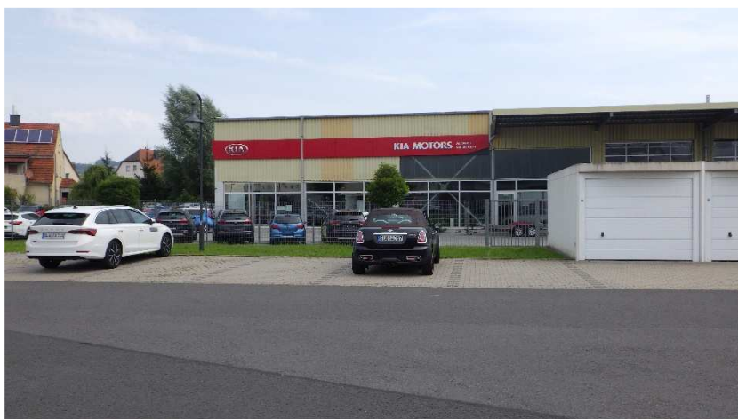
Foto 9 Der Eingriffsbereich neben der ersten der angrenzenden Garagen. Das eingeschossige Gebäude soll direkt an die erste Garage anschließen.
